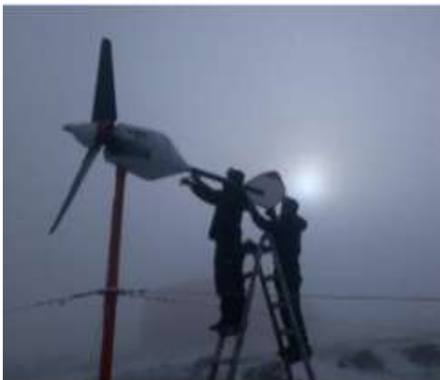
Imagen 4. Instalación de la turbina eólica.
