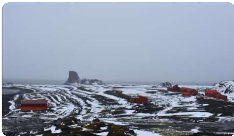
Figura 9. Registro fotográfico de las instalaciones de la Base Científica Pedro Vicente Maldonado del Ecuador.
