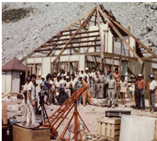
La casa prefabricada en construcción. Foto: archivo personal ALM (RA) Edgar René Spicker Guzmán.
